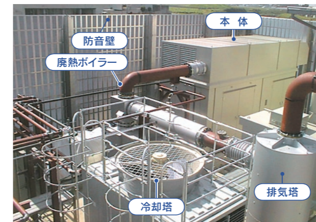
群馬工場に導入したコージェネレーションシステム
