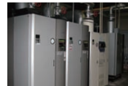
天然ガスボイラーを導入
