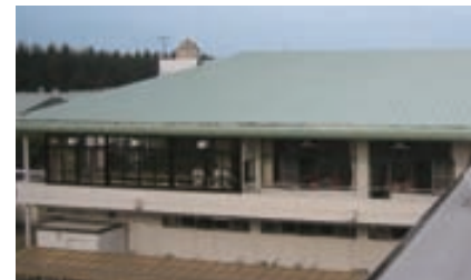
遮熱塗装を行った屋根
