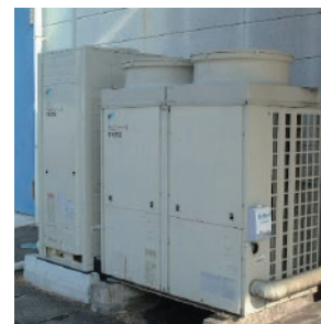
省エネ型空調装置
