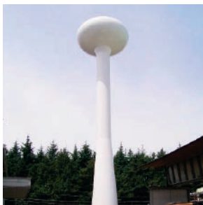
*高架水槽塗装工事
