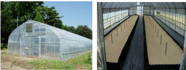
【養生ハウス外観・内部の様子】
